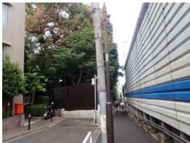
南側からの外観
